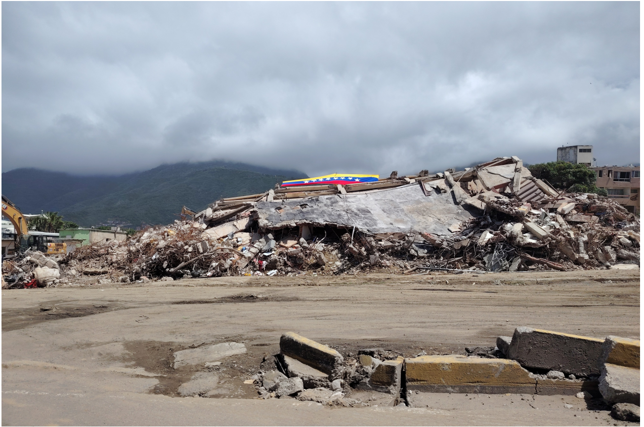
Una bandera ondea sobre los escombros de un edificio colapsado en el sector El Caribe, una de las zonas más afectadas del estado La Guaira. 19 de julio de 2026. (Foto: Graciela Portillo)
